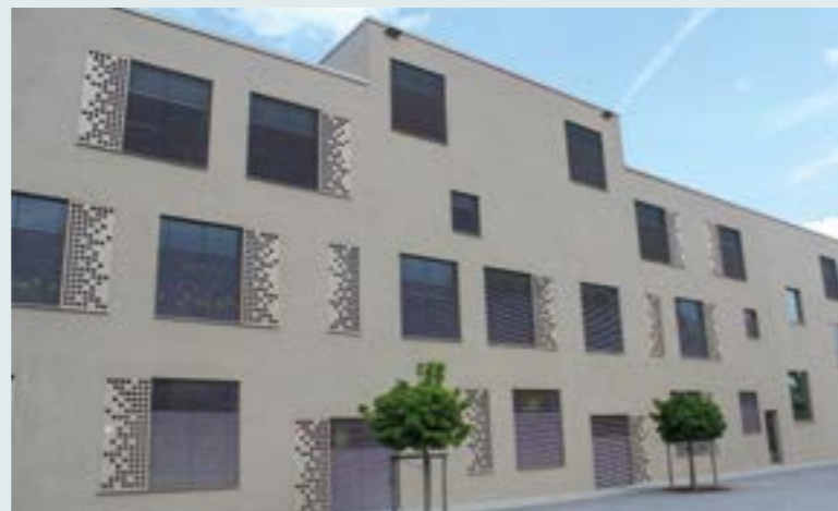
Im Juni 2017 wurde das Gebäude Nik Welter, für die Maison relais und das Zyklus 1 der Merscher Grundschule eingeweiht.
